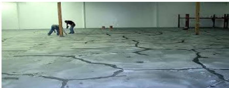
Figure4-3 :Shrinkage Cracks
